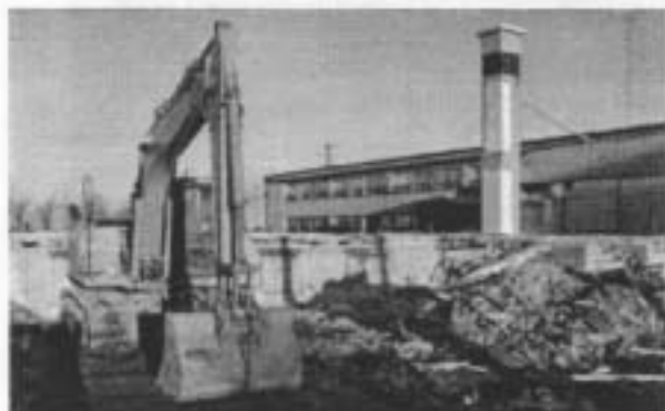
Après le passage du pic du démolisseur
