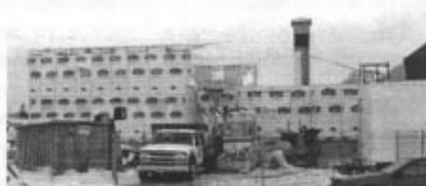
La nouvelle construction, rue Nérée-Beauchemin, vers la mi-décembre
