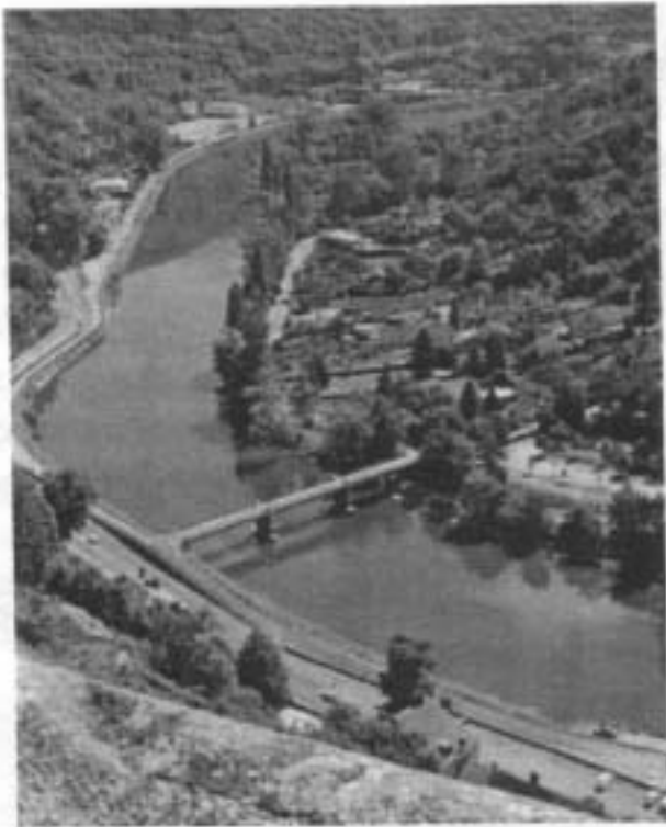
Vue vraiment spectaculaire de la Doubs du haut des remparts construits par Vauban
